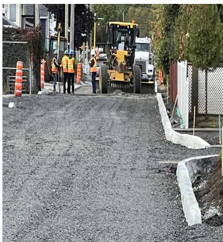
7,3 M$ seront injectés dans la réfection du boulevard Jacques-Cartier et l'avenue Benoit-Quimper en 2025.
